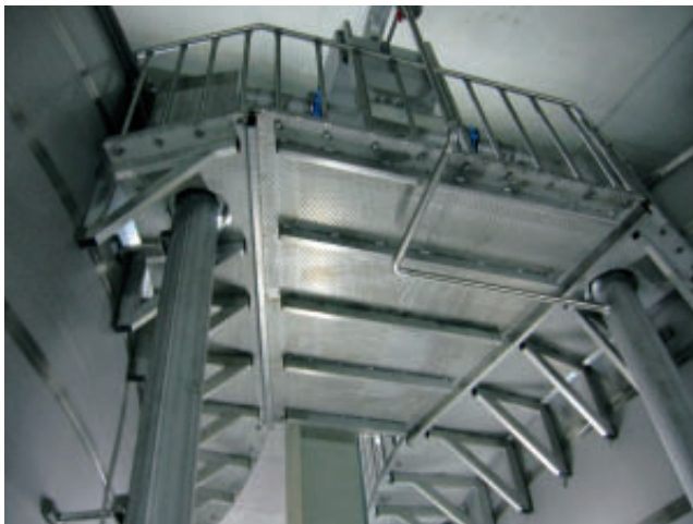
Abb. 4: Bedienpodest (von unten) für sichere und einfache Kontrolle
