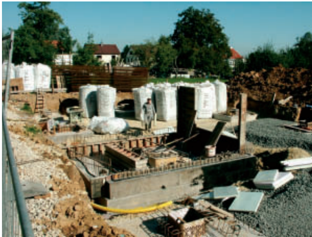
Abb. 2: Fertigung der Bodenplatte mit Vertiefung für die Rohrleitungen
