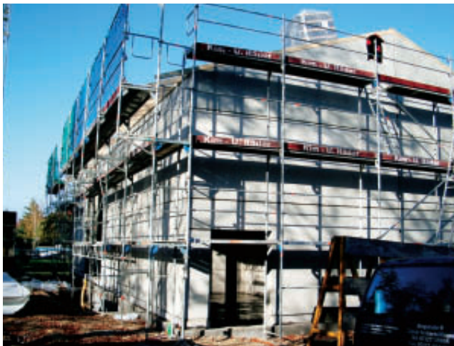
Abb. 3: Gebäudeerrichtung mit Betonfertigteilen
