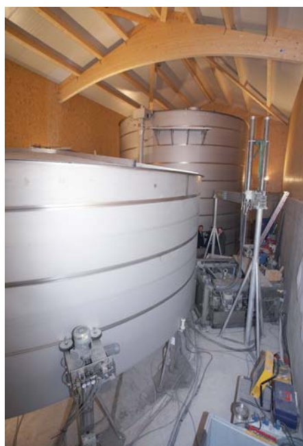
HydroSystemTank-Fertigung vor Ort.
