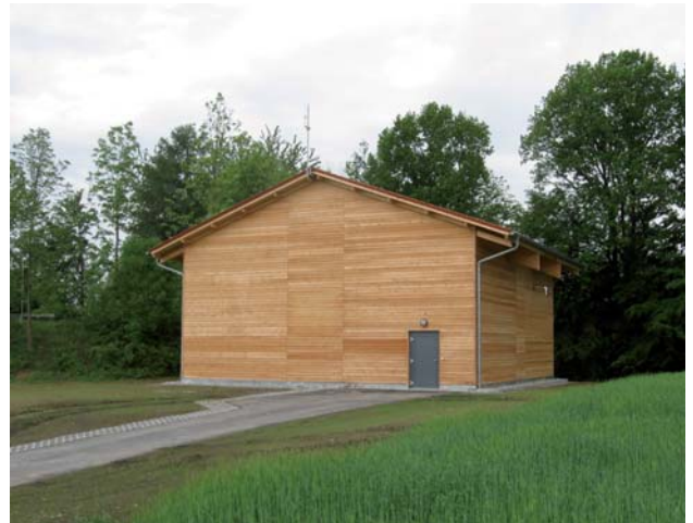
Hochbehälteranlage mit 400 m 3 .
