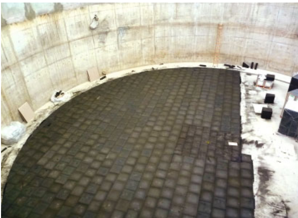
Bild 2. Foamglasplatten zur Bodenisolierung.
