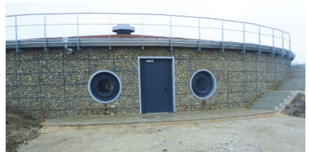
Bild 5. Außenansicht des sanierten Wärmespeichers nach Fertigstellung.
