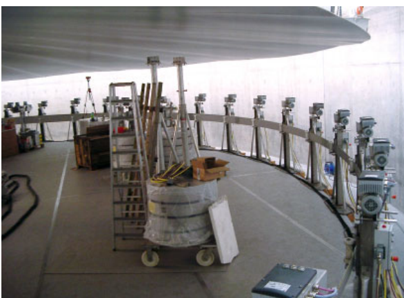
Bild 3. Fixierte Stützen für die Mantelfertigung.
