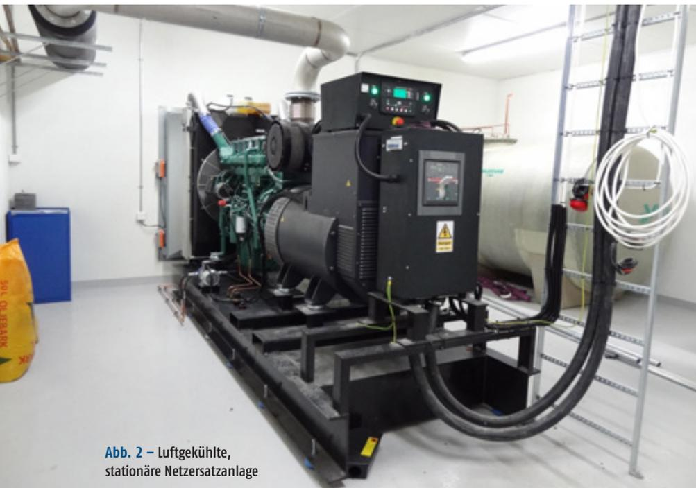
Abb. 2 – Luftgekühlte, stationäre Netzersatzanlage
