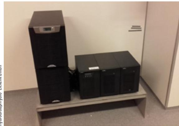
Abb. 1 – USV 400 V für UV-Anlage und Ozonerzeugungsanlage mit USV 230 V für Steuerspannung
