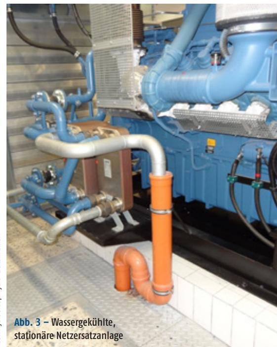
Abb. 3 – Wassergekühlte, stationäre Netzersatzanlage
